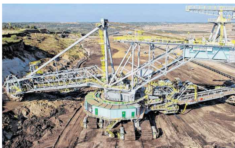
Ein Schaufelradbagger fördert im Tagebau Vereinigtes Schleenhain bei Leipzig Braunkohle. Stanislaw Tillich machte sich gestern erneut für den Energieträger stark. Foto: dpa
