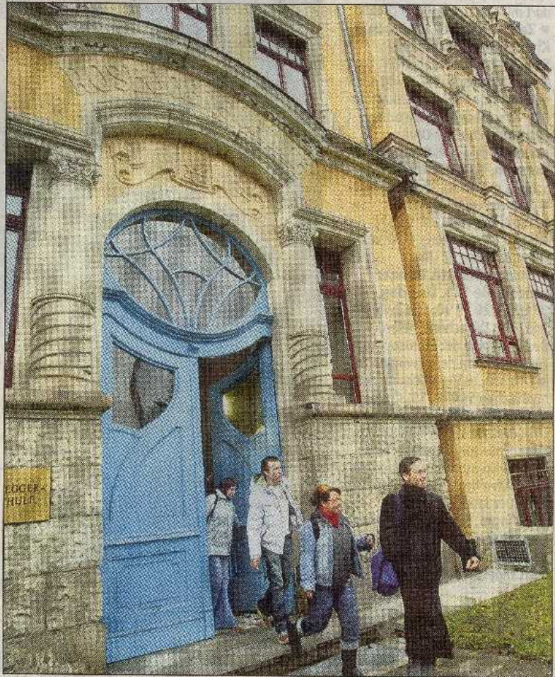
Das Roseggerhaus an der Wasastraße: Von außen sieht es gut aus. Doch innen muss die Stadt noch eine Million Euro investieren, damit dort im Sommer 2006 die Mittelschule Radebeul-Mitte eröffnet werden kann. Foto: Thomas Adler
